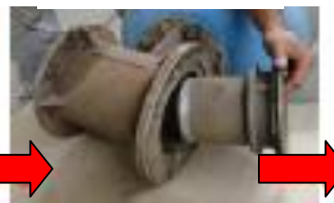
Tubo interno retirado
