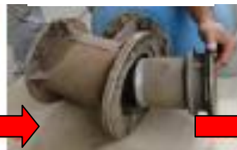
Tubo interno retirado
